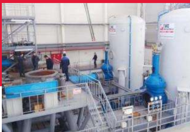
Стенд испытаний вертикальных насосов и агрегатов
